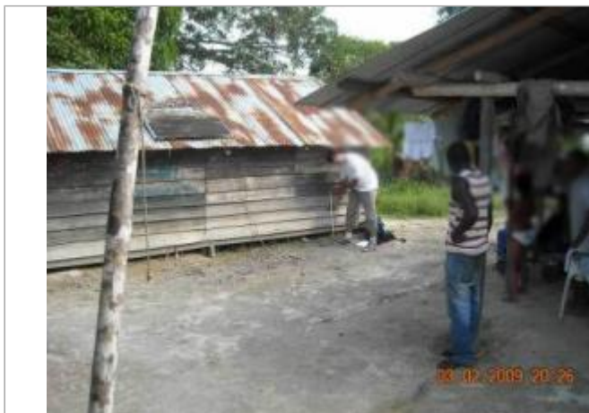
Vue globale du bâtiment
