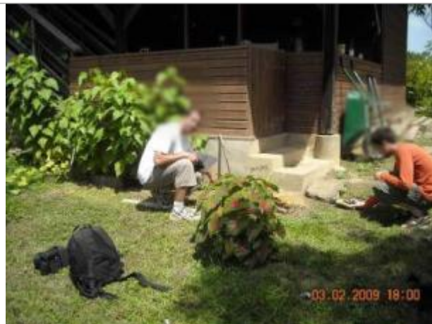
Vue globale du bâtiment
