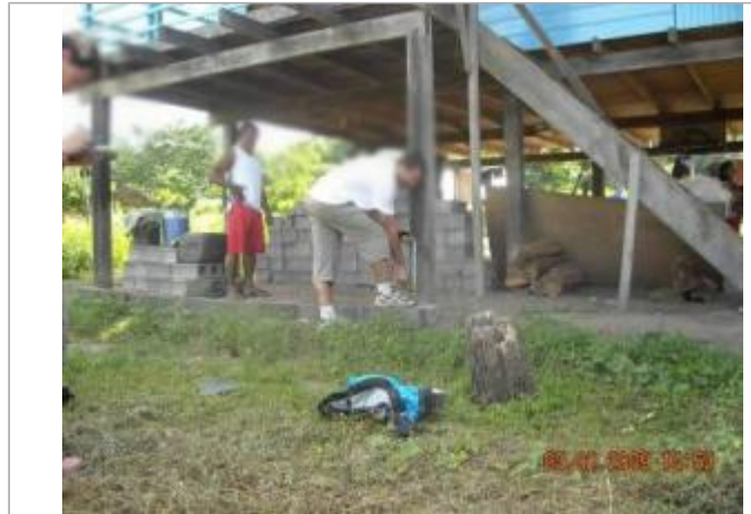
Vue globale du bâtiment
