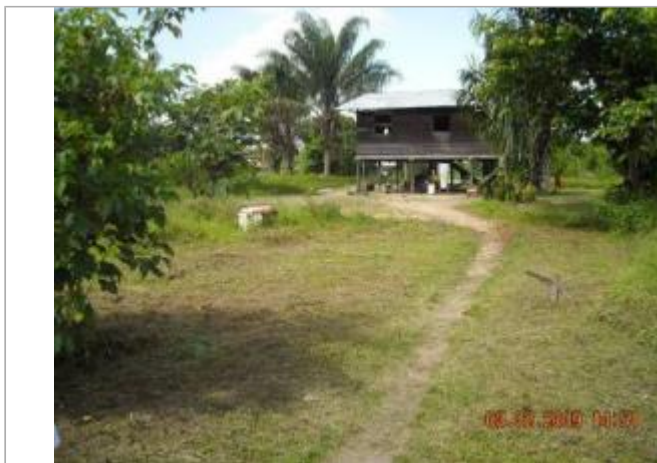
Vue globale du bâtiment
