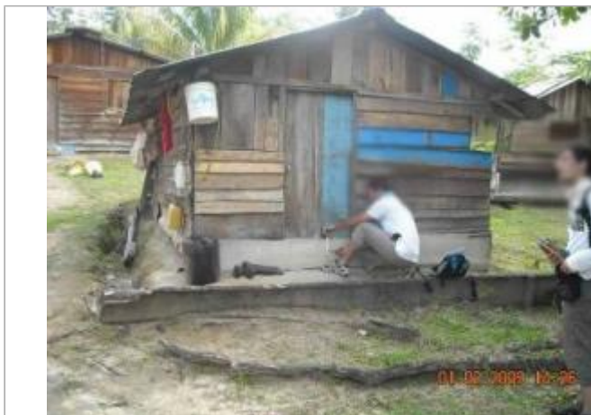
Vue globale du bâtiment
