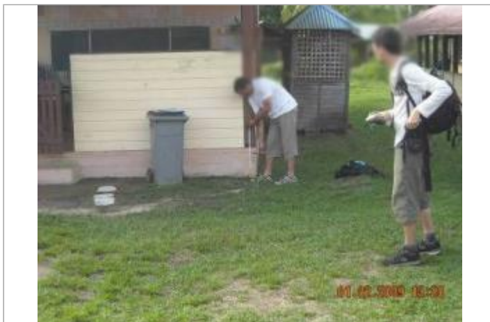
Vue globale du bâtiment
