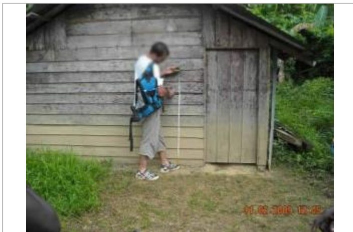
Vue globale du bâtiment
