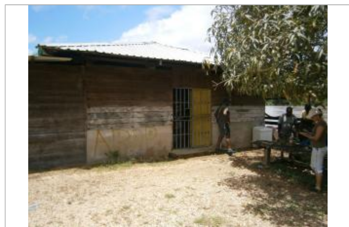
Vue du support de la mesure
