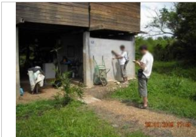
Vue globale du bâtiment
