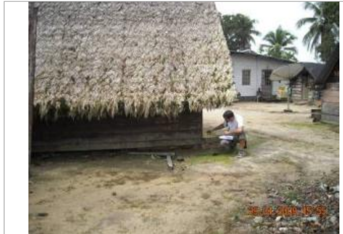
Vue globale du bâtiment
