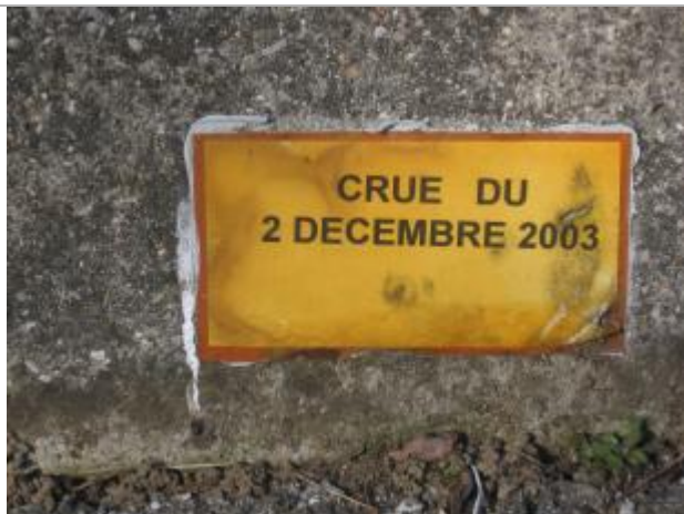
Repère de crue avec ancienne plaque plastique
