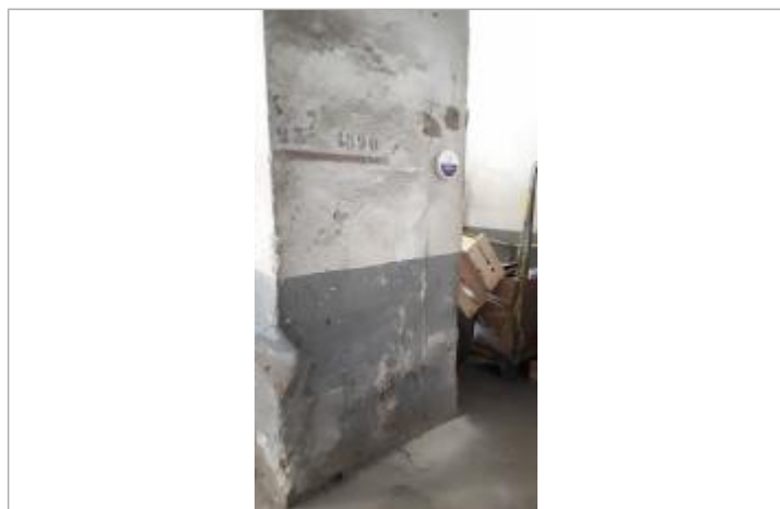
Repère de crue, jour de pose et ancien repère de crue
