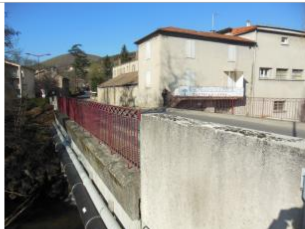
Pont situé en aval immédiat de l'ancienne usine Canson
