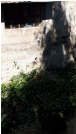
Vue éloignée du repère de crue
