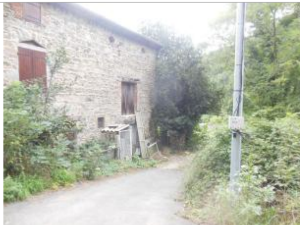
Façade d'habitation avec repère de crue sur le muret et repère géodésique IGN
