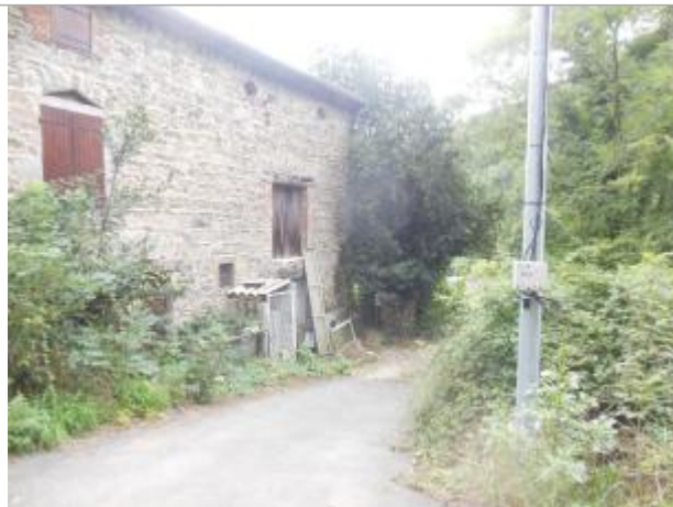
Façade d'habitation avec repère de crue sur le muret et repère géodésique IGN
