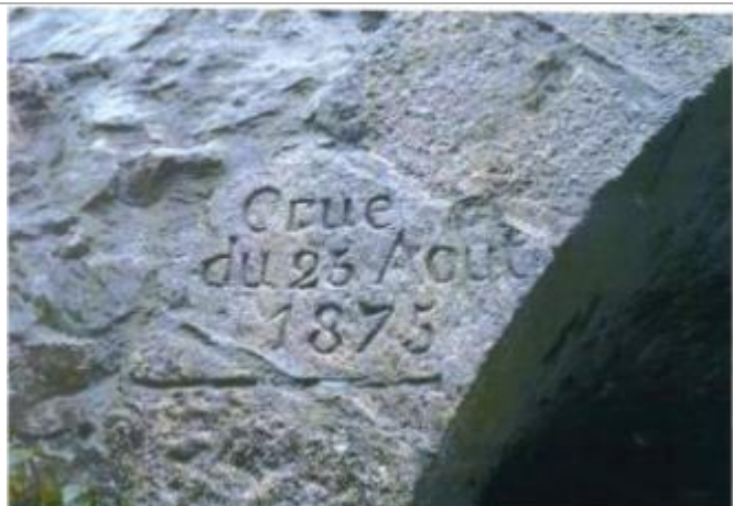
Pierre gravée de l'arche du Pont Girardon - coté amont et rive gauche de la Déôme
