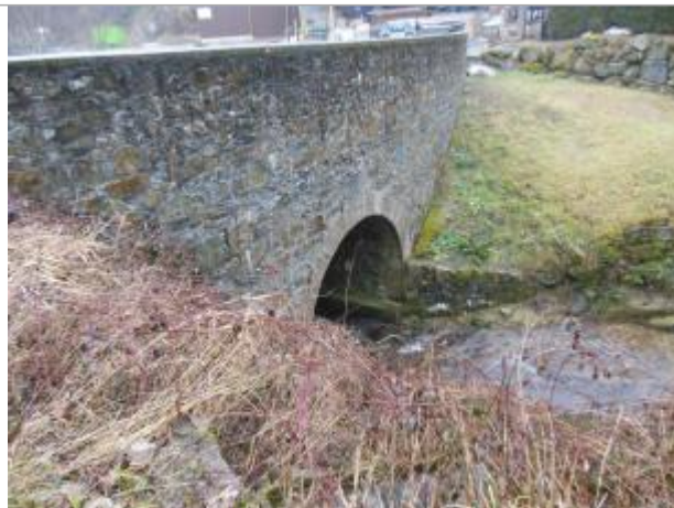
Pont Girardon - vue de la rive gauche, en amont du Pont Girardon
