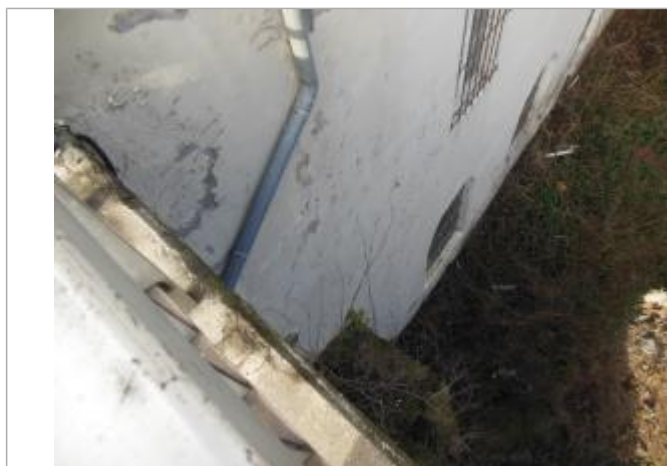
Repère Pont Chevalier - vue de la rive droite de la Cance
