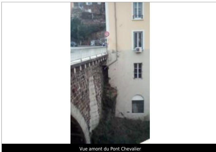
Vue amont du Pont Chevalier
