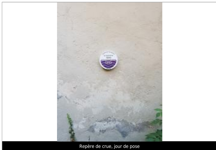
Repère de crue, jour de pose
