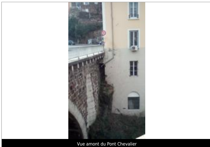
Vue amont du Pont Chevalier
