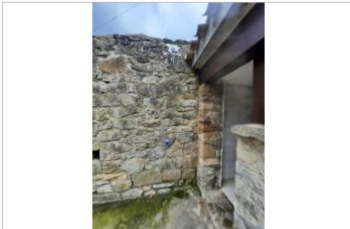
site au niveau du pont Vieux
