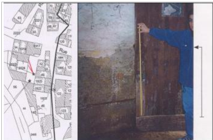
Vue du site
