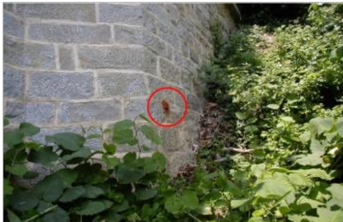
Pont culée droite amont
