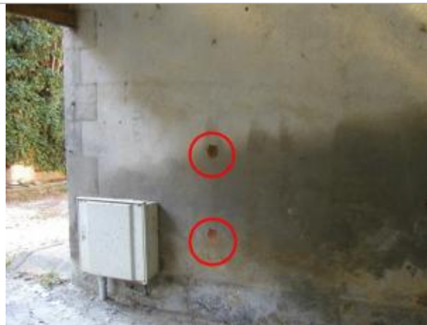
Façade Nord-Est - rive droite
