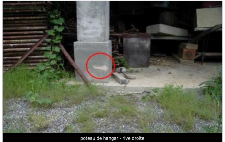
poteau de hangar - rive droite
