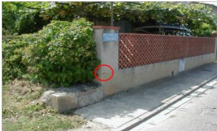
angle de poteau de muret
