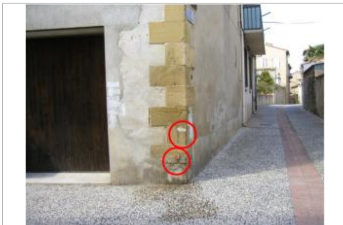
entrée droite garage - rive gauche
