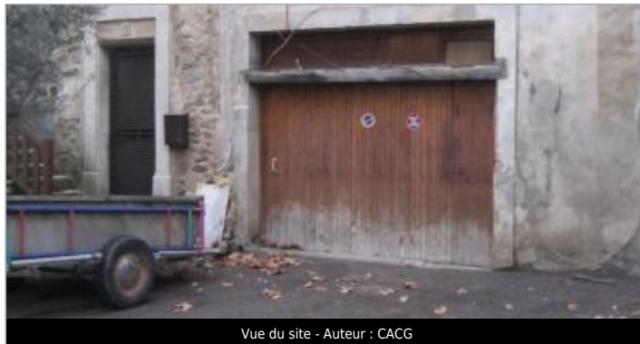
Vue du site - Auteur : CACG
