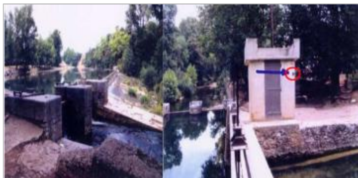
façade de l'abri de rangement - rive droite
