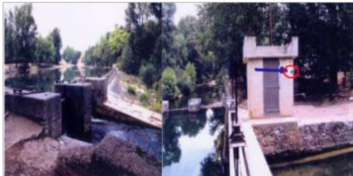
façade de l'abri de rangement - rive droite
