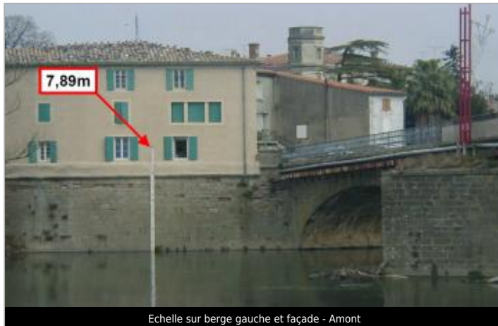
Echelle sur berge gauche et façade - Amont
