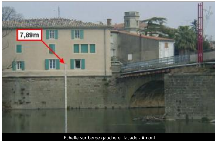
Echelle sur berge gauche et façade - Amont
