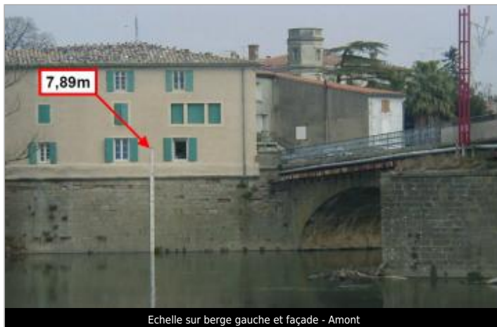
Echelle sur berge gauche et façade - Amont
