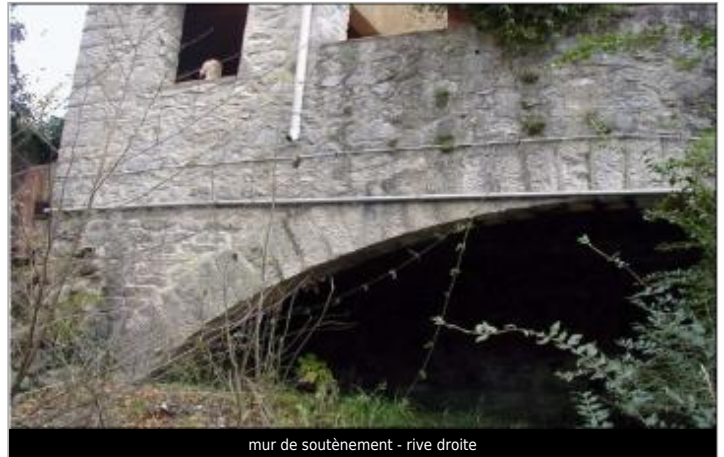
mur de soutènement - rive droite
