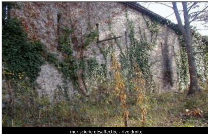
mur scierie désaffectée - rive droite
