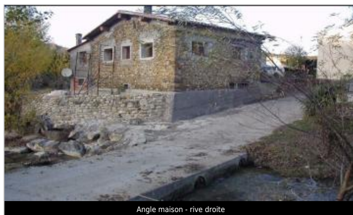
Angle maison - rive droite
