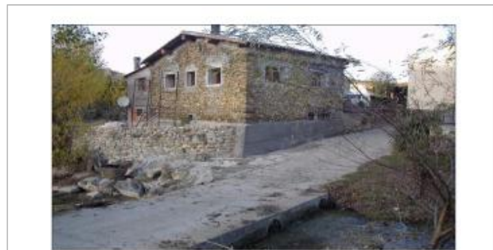
Manifestement le coin de la construction a fait l'objet de travaux de renforcement et de consolidations récents, ce serait peut être la cause de la disparition de ce repère de crue.
