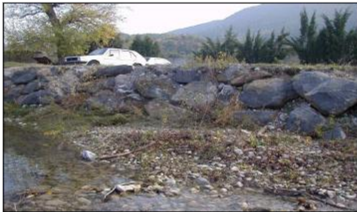
murette, grosses pierres - rive gauche
