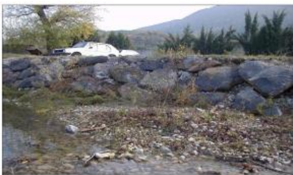
Le déversement de gros blocs de pierre en vue de consolider la rive gauche, pourrait être la cause de la disparition du repère. Photographie du site présumé.
