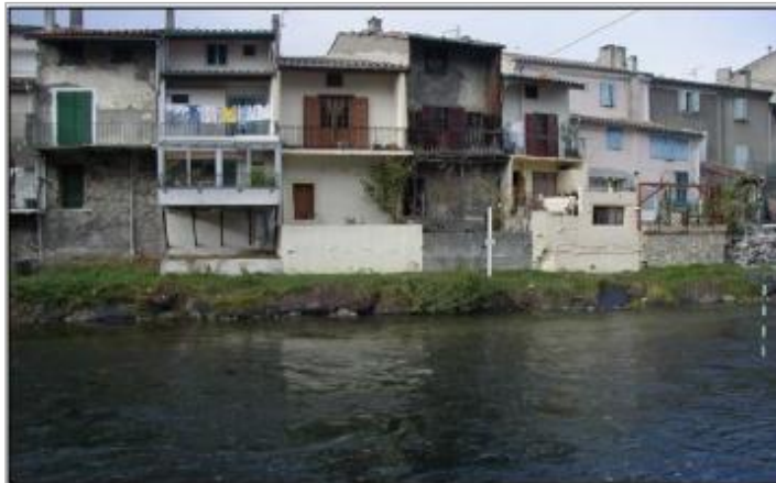
mur de soutènement - rive gauche
