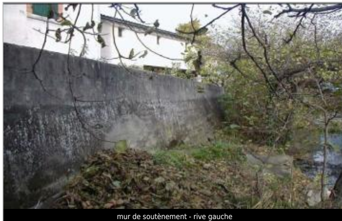
mur de soutènement - rive gauche
