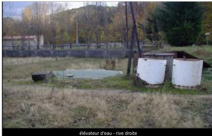
élevateur d'eau - rive droite
