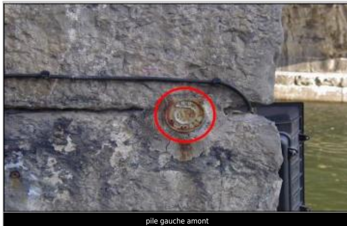
pile gauche amont
