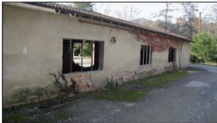
mur bâtiment désaffecté - rive droite
