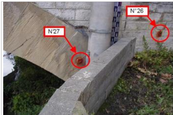
culée gauche aval
