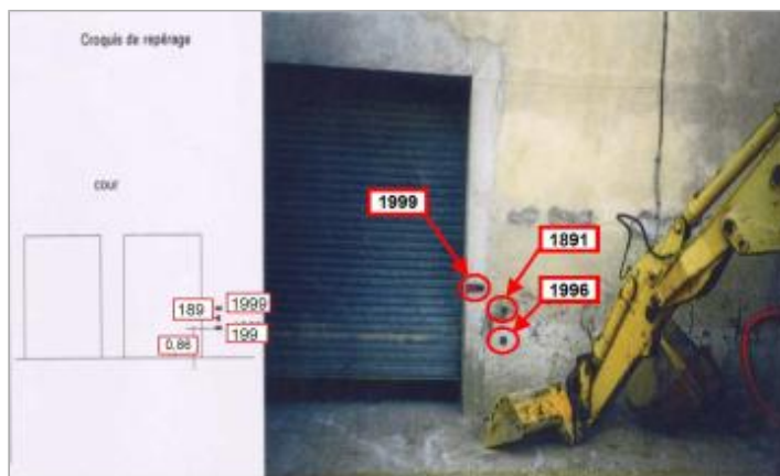
piédroit du portail de la cour - rive droite
