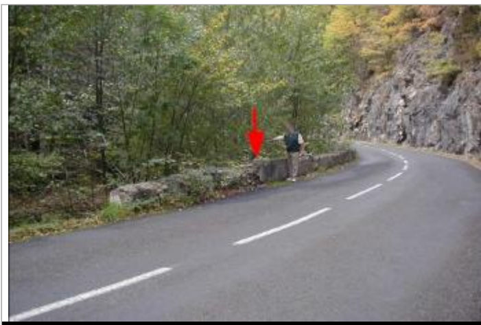
mur de soutènement - rive gauche
