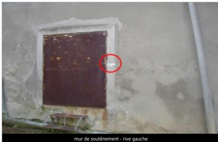
mur de soutènement - rive gauche
