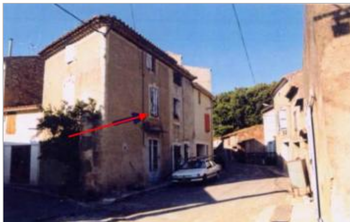
façade -s/ fenêtre du 1er étage - rive gauche
