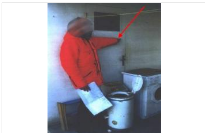
porte intérieure de la lingerie - rive droite
