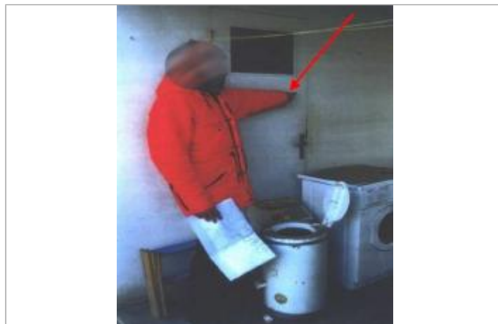
porte intérieure de la lingerie - rive droite
