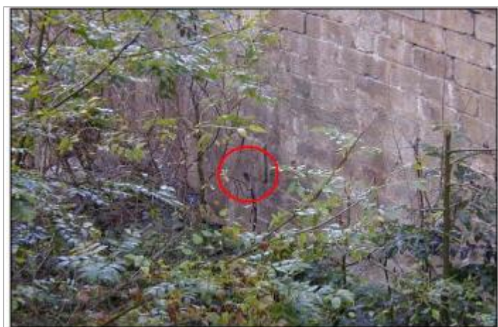
pont - culée droite amont
