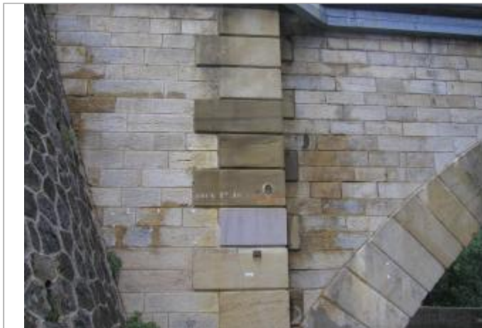
culée gauche amont
