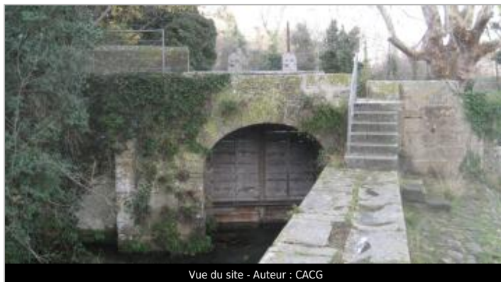
Vue du site - Auteur : CACG
