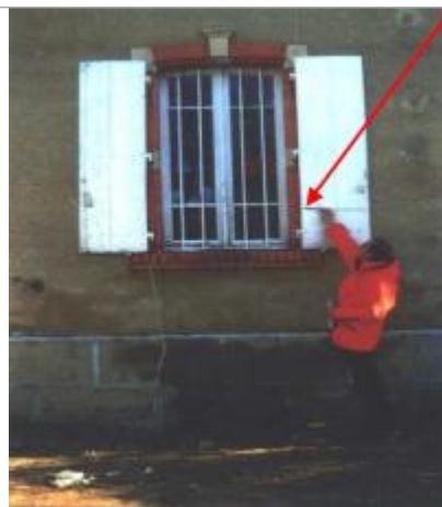
façade de la Poste-volets - rive droite
