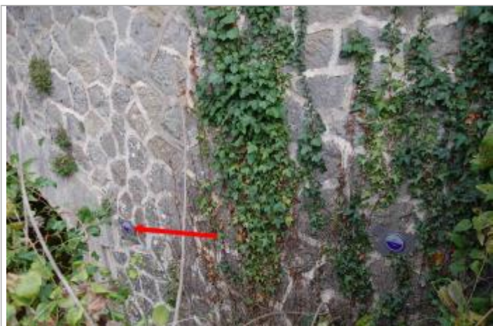
repère normalisé de la crue de 1910
