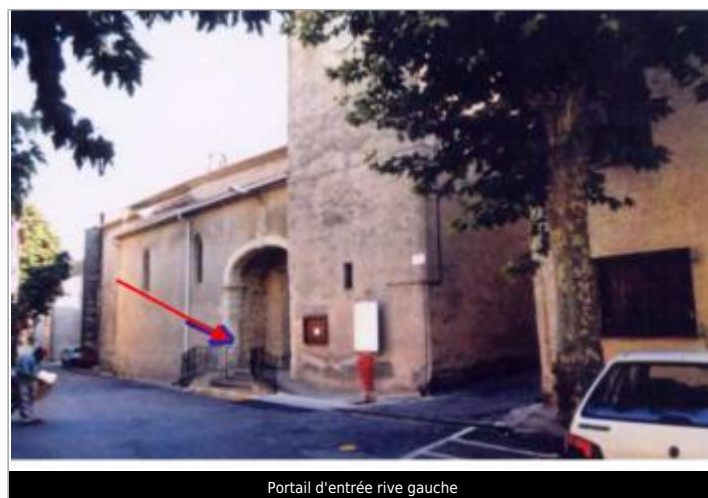
Portail d'entrée rive gauche
