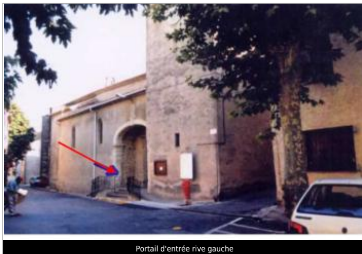
Portail d'entrée rive gauche
